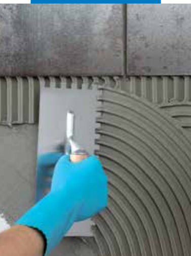
Az Ultralite S1 felhordása falra fogazott simítóval
