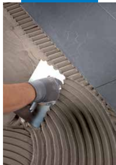
A ragasztó felhordása padlóra 9 mm-es félkörfogazású fogazott simítóval
