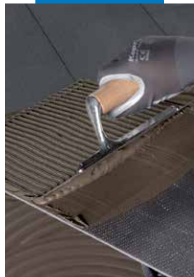
A ragasztó felhordása a burkolólap hátoldalára
