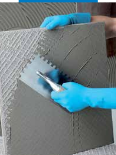
Az Ultralite S1 felhordása a burkolólap hátoldalára
