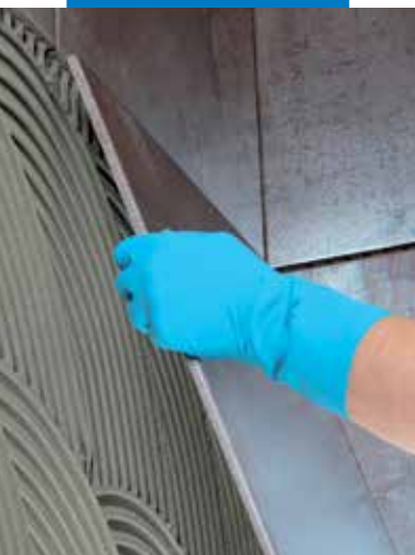
Nagyméretű kerámia burkolólap ragasztása falra
