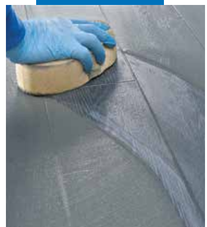
A fugák végső tisztítása kemény cellulóz szivaccsal
