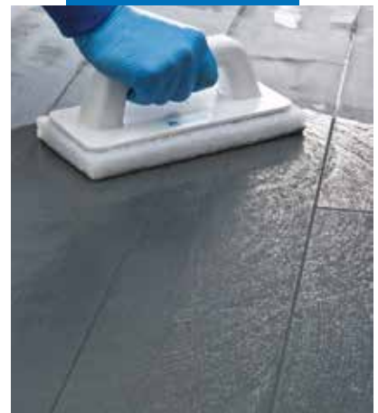
Fugatisztítás Scotch-Brite®-tal (részben megkötött termékénél)
