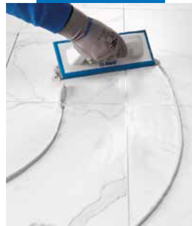
Ultracolor Plus felvitele márványos felületű kerámia padlólapokra fugázógumival
