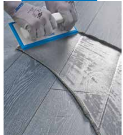
Ultracolor Plus terítése padlón gumisímitóval
