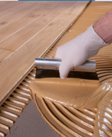
Ultrabond P990 1K terítése
