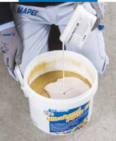
Az edző (B komponens) beleöntése a törzsgyantába (A komponens)
