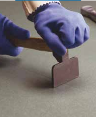
A tekercsek közötti illeszkedések lenyomása
