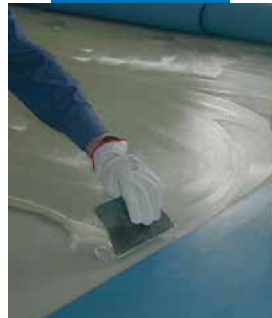
Ultrabond Eco V4 SP felhordása - Szent Martin Idősek Otthona - Olaszország
