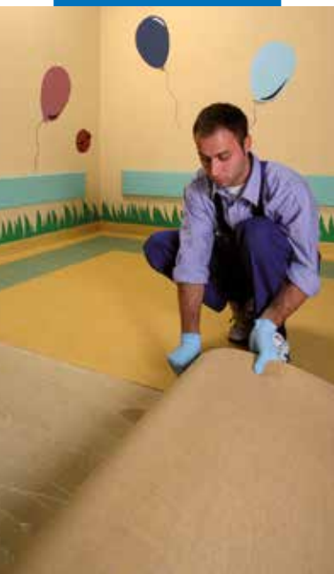
Természetes juta hátoldalú linóleumburkolat fektetése
