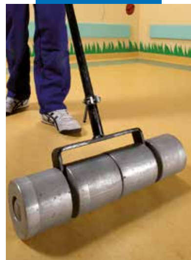
Linóleumburkolat simítása
