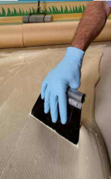
Ultrabond Eco 520 felhordása
