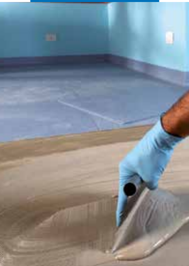
Ultrabond Eco 380 felhordása
