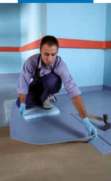
PVC padlóburkolat fektetése
