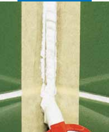
Mapesil AC felhordása
