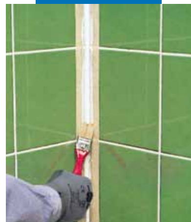
Hézagkitöltés simítása szappanos vízzel és kis ecsettel
