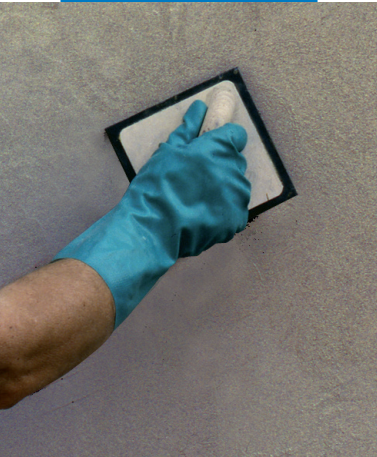
PoroMap Finitura felületének besimítása szivacsos simítóval
