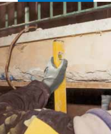
Erkély-homlokfelület javítás: fa zsalu beállítása
