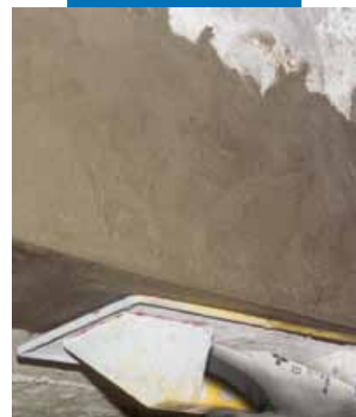
Betongerenda helyi javítása
