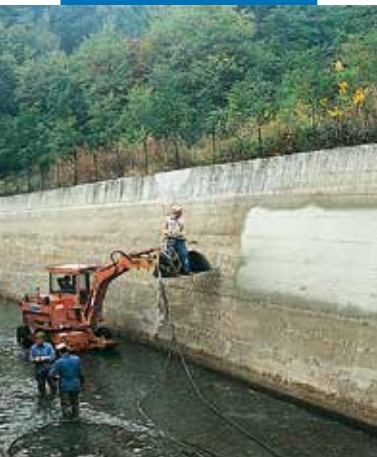
Planiseal 88 felhordása szórópisztollyal vízerőmű üzemvíz csatornájában
