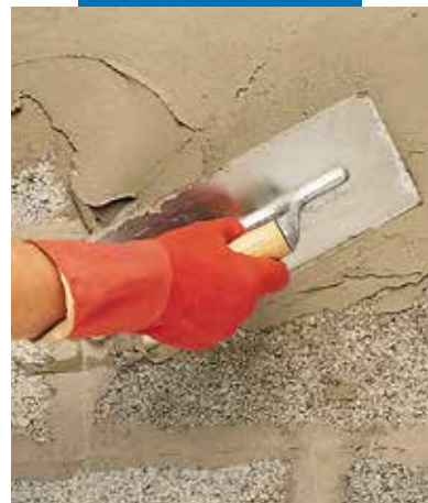
Planiseal 88 felhordása simítóval
