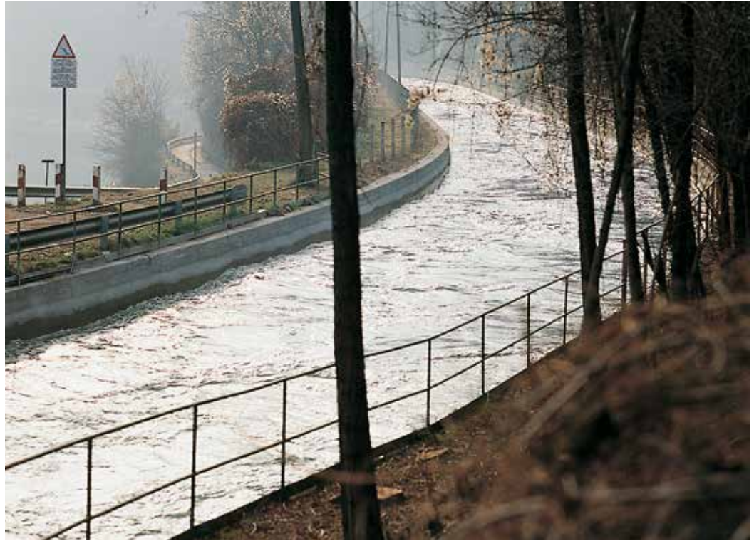
Bertini vízerőmű üzemvíz csatornája - Como, Olaszország; a felületeket Planiseal 88-cal kezelték
