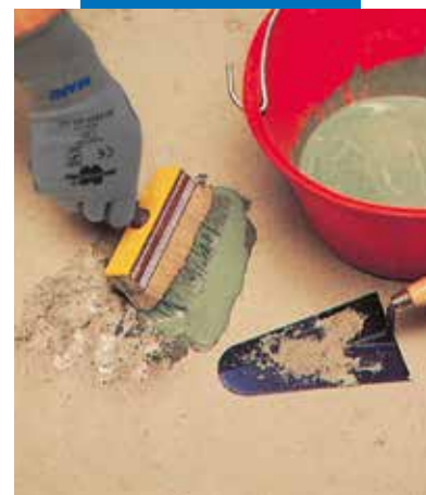
Padlójavítás: a tapadóhíd felhordása
