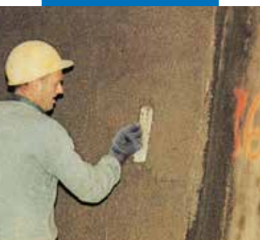
Planicrete-tel kevert cementvakolat - Ville Marie autópálya alagút, Montreal, Kanada
