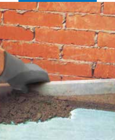
Planicrete-tel készített cementkötésű esztrich felhordása
