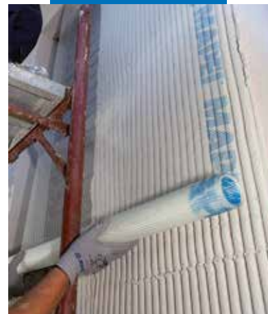
Mapetherm Net bedolgozása az első simítórétegbe
