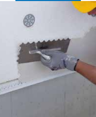
Mapetherm Dripnose Bead felhordása Mapetherm AR1 Light-tal
