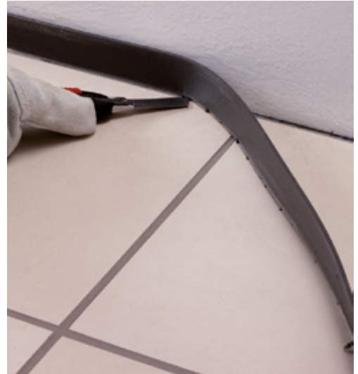
A fugázóhabarcs megkeményedése után vágja le a fölösleges Mapesonic Strip szalagot
