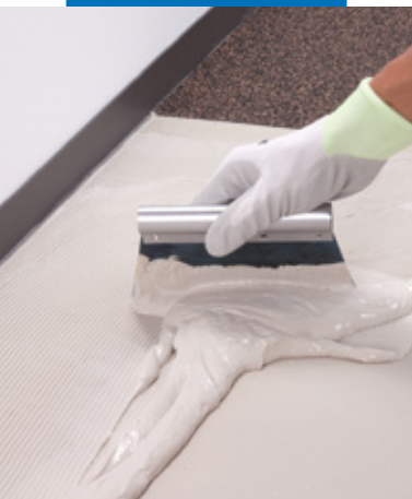
Az aljzat megfelelő előkészítése után a ragasztó felhordása a hangszigetelő lemez felragasztására
