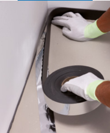
Öntapadós Mapesonic Strip felhelyezése a szoba kerülete mentén
