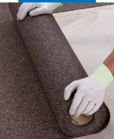
A hangszigetelő anyag tekerceinek kitérítése a védendő helyiség padlójára
