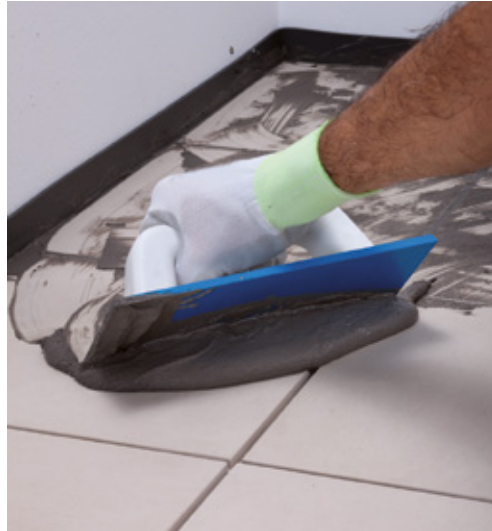
A burkolat fugahézagainak kitöltése
