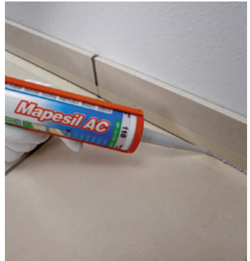
A függőleges és a vízszintes burkolatfelületek közötti hézag kitöltése a MAPEI különféle színekben rendelkezésre álló hézagkitöltő-anyagaival
