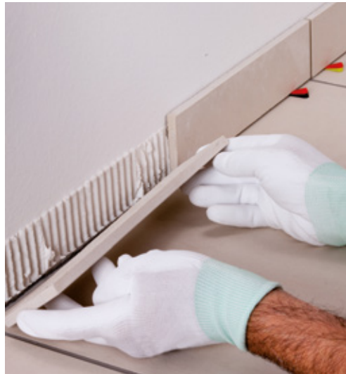
A lábazati burkolólapok felhelyezése, hogy a burkolólap ne kerüljön közvetlen érintkezésbe a padlóburkolattal
