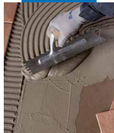
Burkolat ragasztása Elastorapiddal
