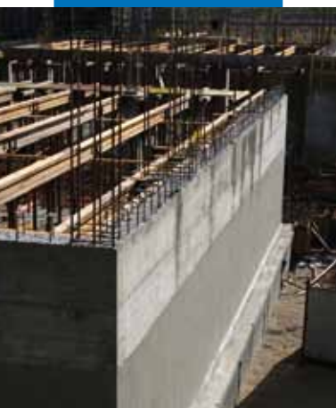
Mapelastic Foundation-nal vízszigetelt, helyszínen készült támfal
