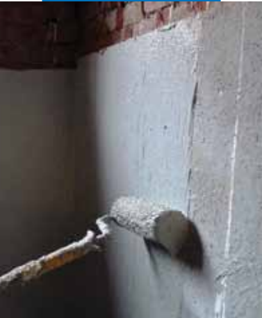
Mapelastic Foundation felhordása hengerrel Planitop HDM Maxi-val kiegyenlített aljzatra
