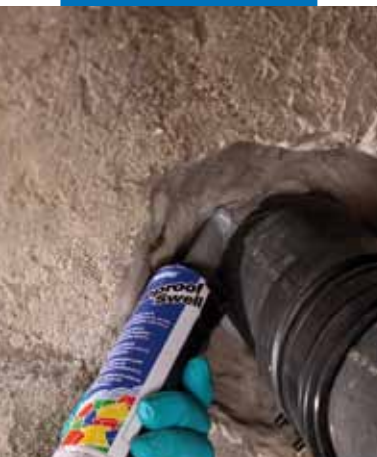
Csőátvezetés tömítése Mapeproof Swell-lel
