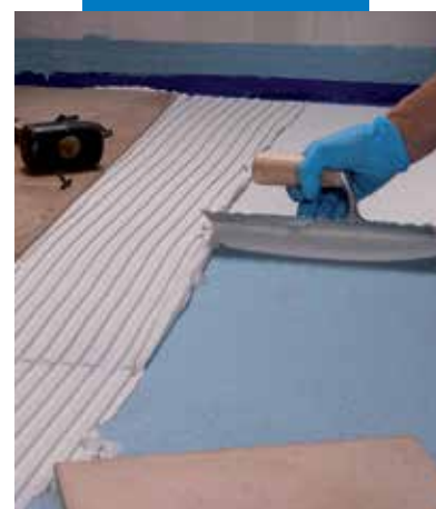
Burkolólapok ragasztása Mapelastic AquaDefense-re
