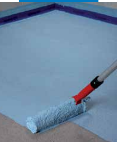
A Mapelastíc AquaDefense első rétegének felhordása esztrichre
