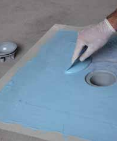
Drain Vertical impregnálása Mapelastíc AquaDefense-vel
