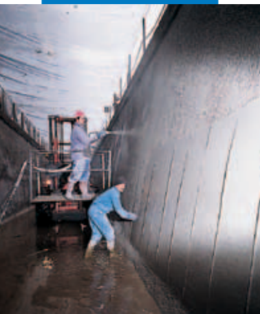
Bertini vízerőmű üzemvízcsatorna - Robbiate (Como) - Olaszország: felületképzés simítóval
