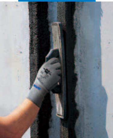
Besimítás szivaccsimítóval
