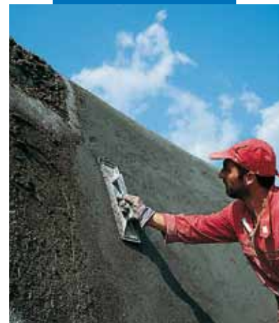
Mapegrout T40 felületképzése simítóval
