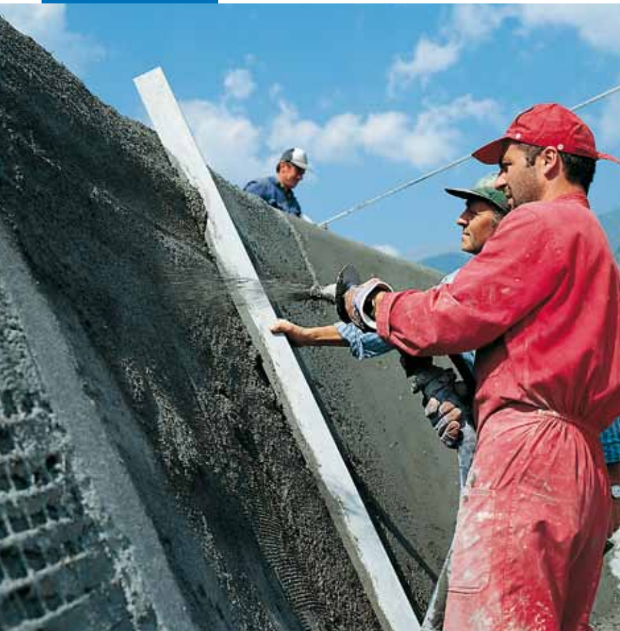
Mapegrout T40 bedolgozása szórással
