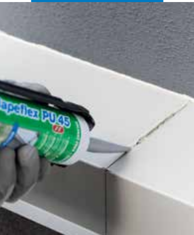
Rugalmas hézagkitöltés szerkezetek csatlakozásainál
