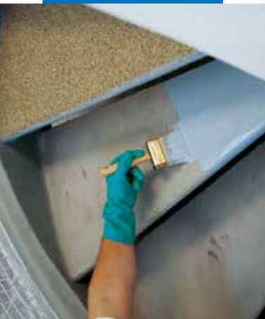
Az első réteg Mapecoat I 24 felhordása betonra
