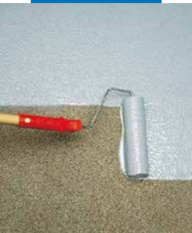
A Mapecoat I 24 felhordása hengerrel
