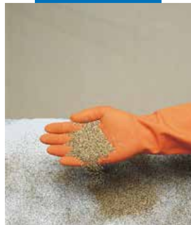
A friss Mapecoat I 24 behintése száraz kvarchomokkal
