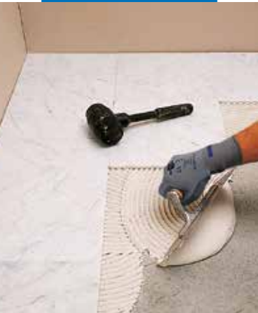
Fehér Carrara márvány fektetése fehér Keraquick S1-kel
