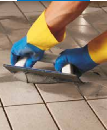
Padlóburkolat fugázása gumisimitóval
