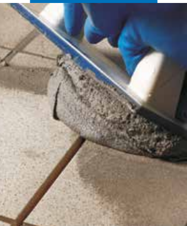
Padlóburkolat fugázása gumisimitóval
