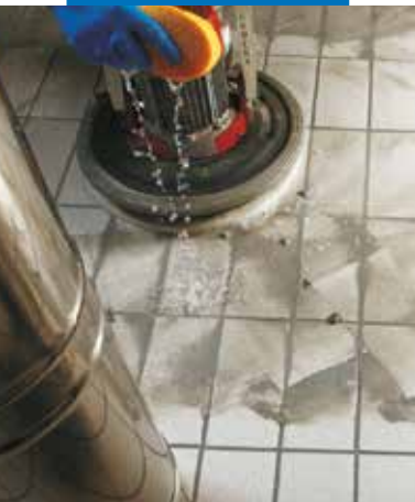
A Kerapoxy P letisztítása Scotch-Brite® súrolófilc-koronggal ellátott egyfejes csempetisztító-géppel
