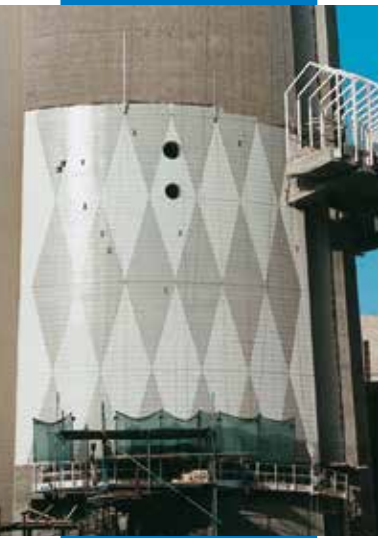
Példa beton burkolására klinker burkolólapokkal Kerabond + Isolastic felhasználásával – Új Távközlési Torony – Kuwait City (Kuwait)
