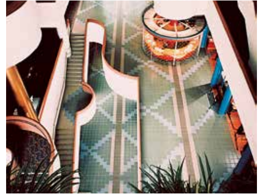
„Porcelain” termékőlap burkolás Kerabond + Isolastic-kal – Civic Center – North York Ontario (Kanada)
