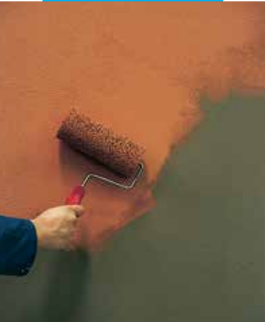
Példa az Elastocolor Rasante feldolgozására porózus szivacsengerrel
