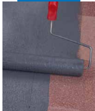
Eco Prim Grip felhordása hengerrel meglévő műkö burkolatra
