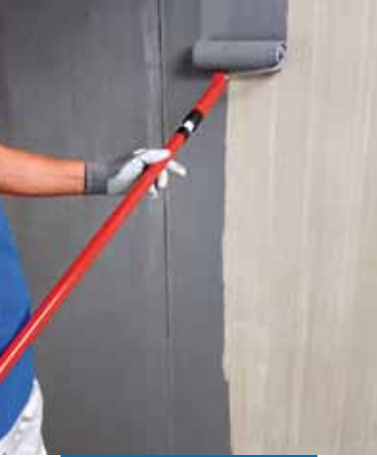
Eco Prim Grip felhordása hengerrel betonfalra
