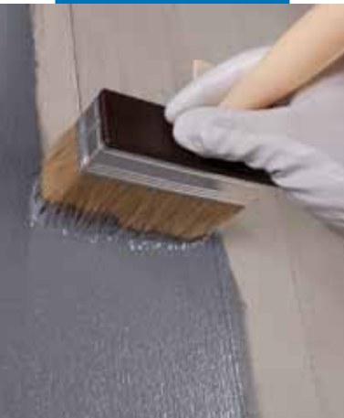
Eco Prim Grip felhordása ecsettel betonfalra
