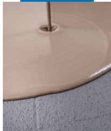
Ultraplan önterülő aljzatkiegyenlítő simítóhabarcs bedolgozása Eco Prim Grip-pel kezelt régi burkolatra
