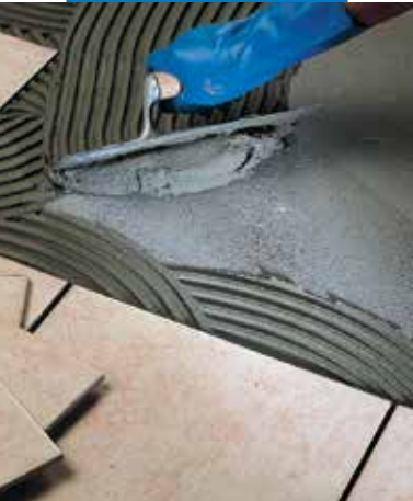
Egyszer égetett burkolólap ragasztása padlóra
