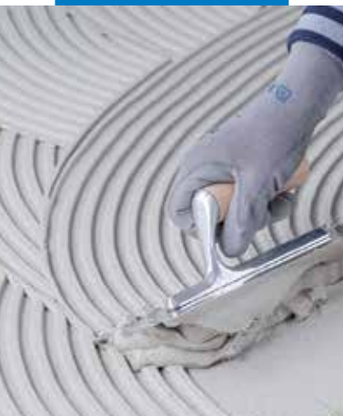
Adesilex P9 fehér terítése
