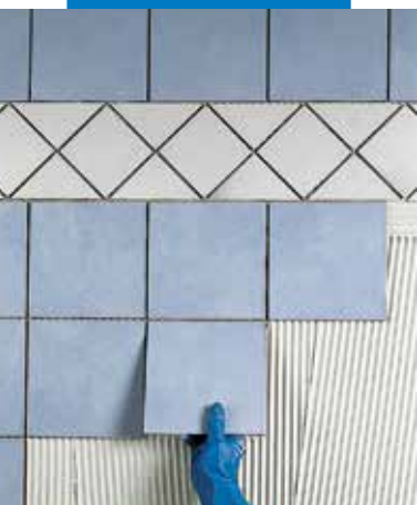
Egyszer égetett burkolólap ragasztása gipszkartonra
